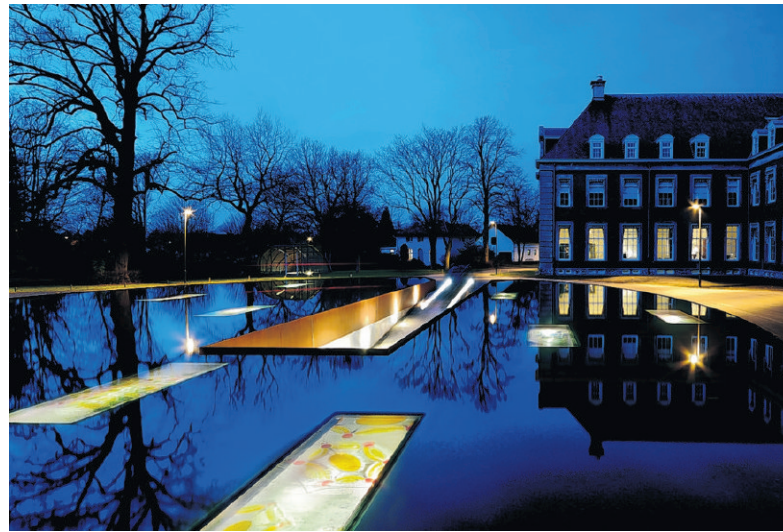
Parkeergarage onder de vijver van Landgoed Hageveld.
